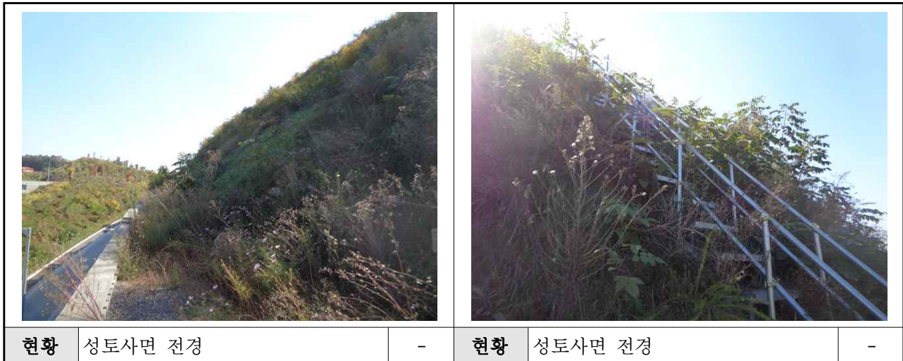
【사진 5.5】 옹벽 상단부 현황
