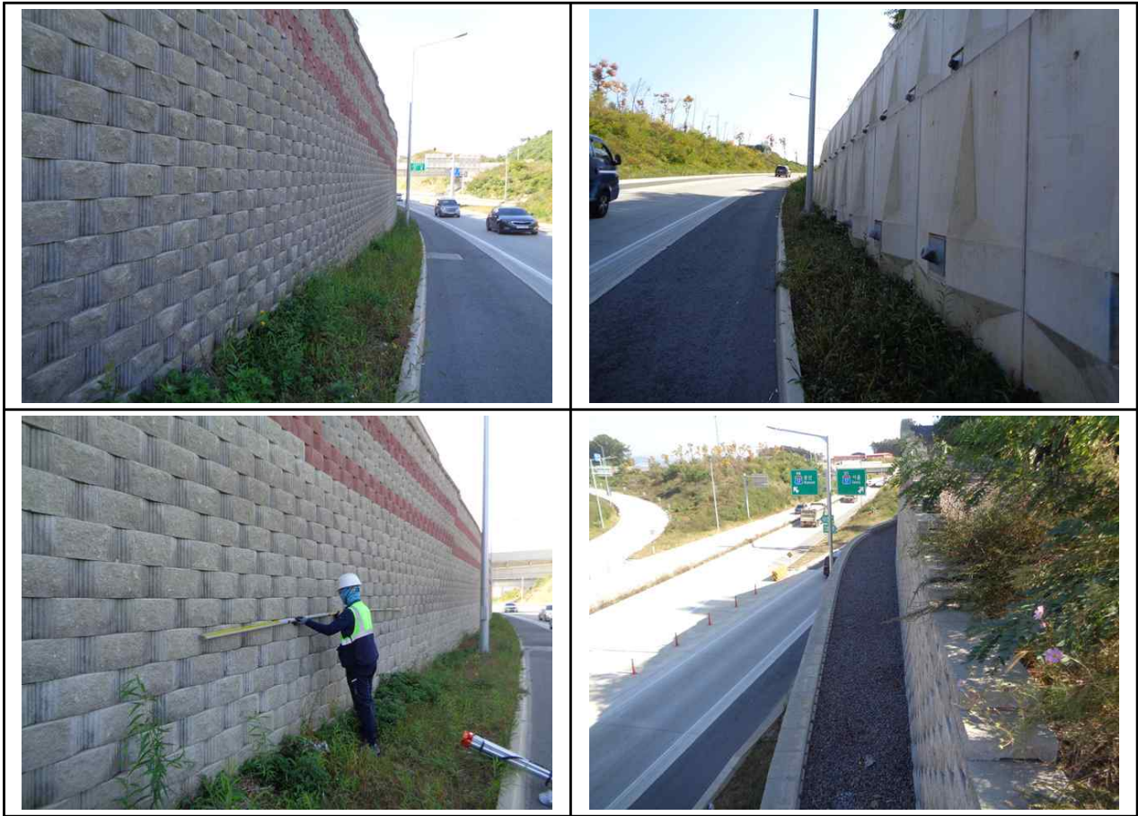
【그림 5.9】 외관조사 전경
